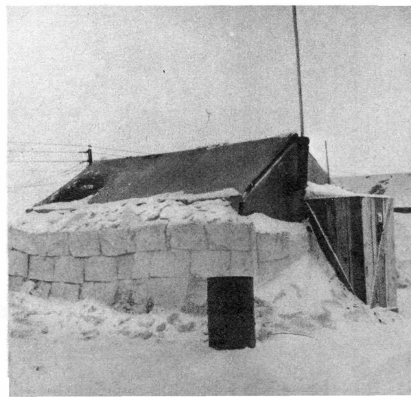
(Sotto). Imitando gli Eschimesi, le costruzioni vengono protette da blocchi di ghiaccio, per diminuire la dispersione di calore.
